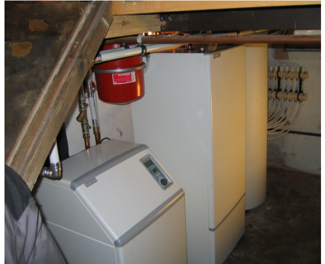
Opstelling in de kelder, hoogte minder dan 1,8 meter
