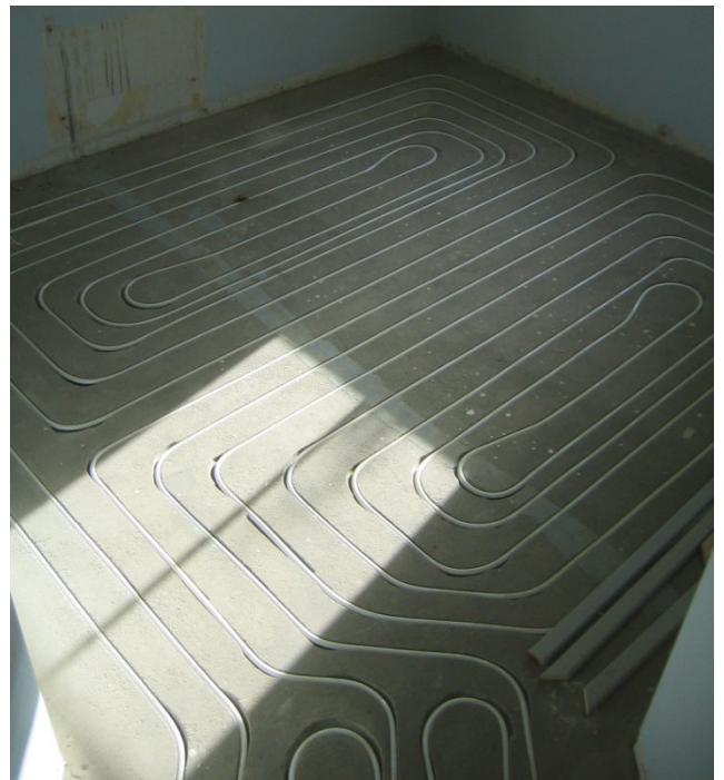
Vloerverwarming ingefreesd in bestaande dekvloer
